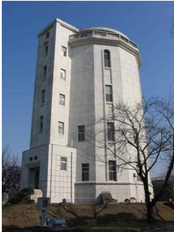
千葉分場高架水槽（土木学会選奨土木遺産・登録有形文化財）
